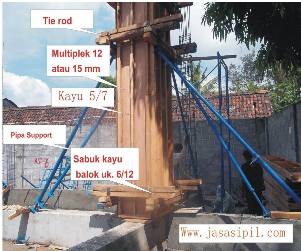
Gambar 2.1 Bekisting Konvensional
