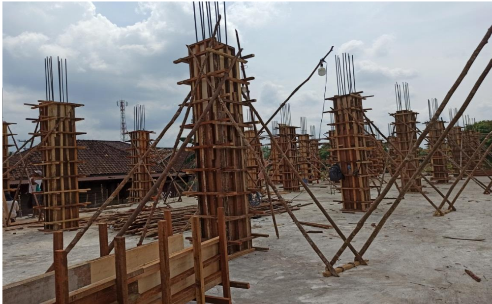
Gambar 2.4 Pemasangan Bekisting
