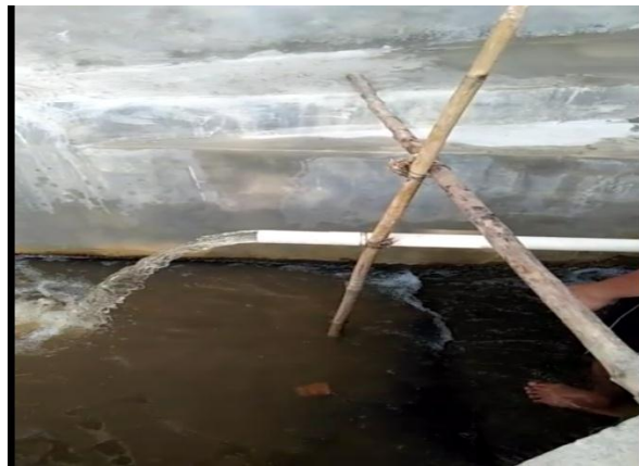
Pemasangan Pipa 2 Inc
