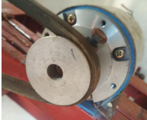
Pemasangan Pulley pada Generator
