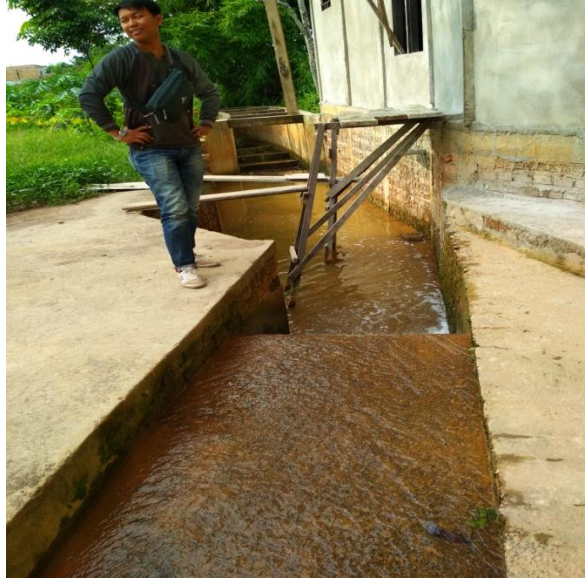
Tempat Pemasangan PLTMH
