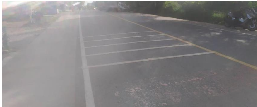
Kondisi rumble strips di SDN 206 Kota Jambi
