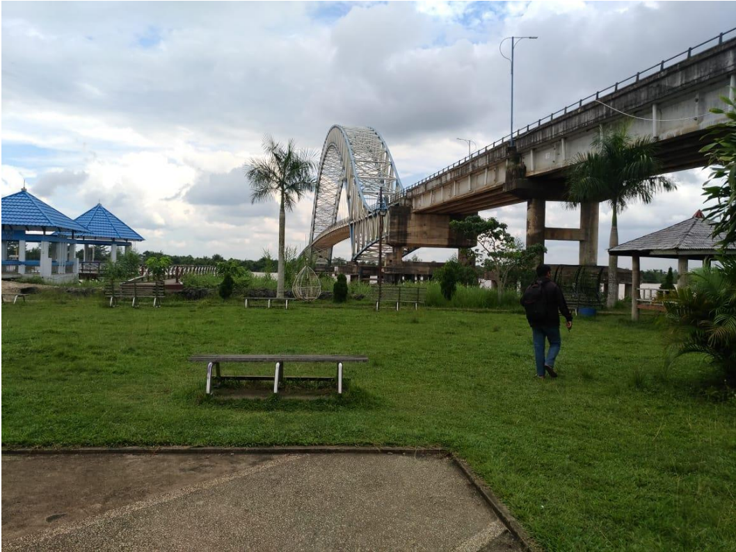
Jembatan Muara Sabak
