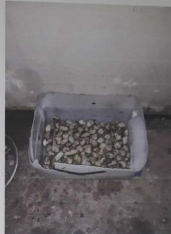
Proses Penambahan Media Kerikil Pada Bak Reaktor Constructed Wetlan
