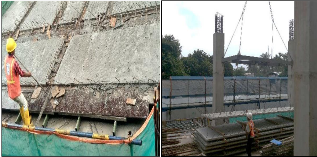
Gambar 2. 3. Pembongkaran Bekisting Precast Half Slab dan Pengangkatan Precast Half Slab ke Stockyard Sumber : SIBIMA Konstruksi (2019)
