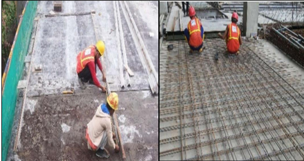
Gambar 2. 1. Perakitan Cetakan Modul Half Slab dan Fabrikasi Tulangan Sumber : SIBIMA Konstruksi (2019)
