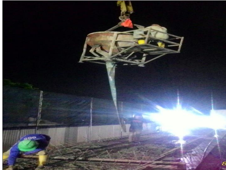
Gambar 2. 2. Pengecoran Precast Half Slab Sumber : SIBIMA Konstruksi (2019)
