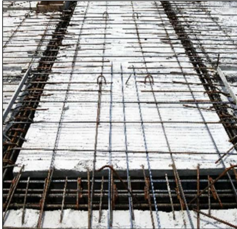
Gambar 2. 5. Perakitan Tulangan Atas Pelat Sumber : SIBIMA Konstruksi (2019)
