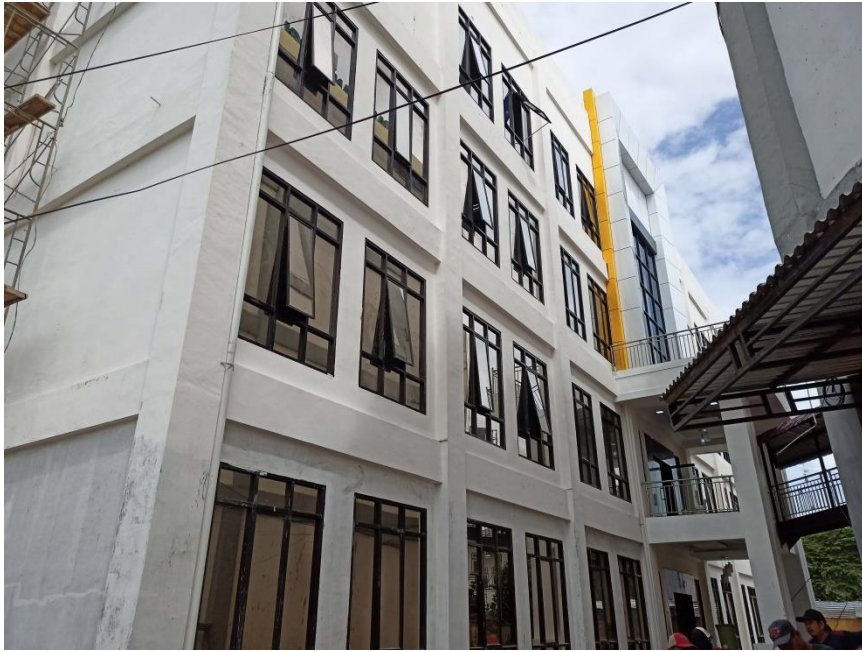
Gambar tampak depan bangunan
