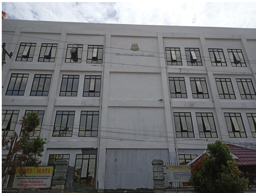
Gambar tampak belakang bangunan
