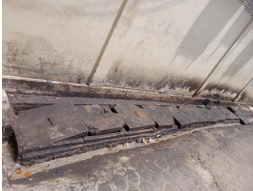
Gambar.9 Bak Pengendapan Air Limbah Rumah Makan
