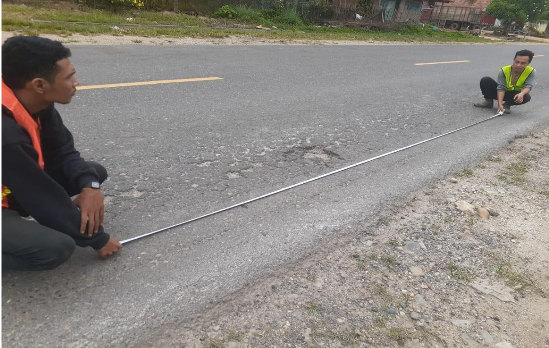
Gambar 5.5 Survei Lubang dilokasi Sumber : Data Olahan, (2022)
