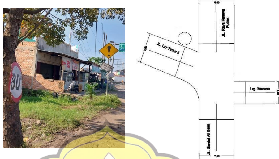
Gambar 4.10 Tiang rambu kecepatan yang tidak sesuai letaknya
