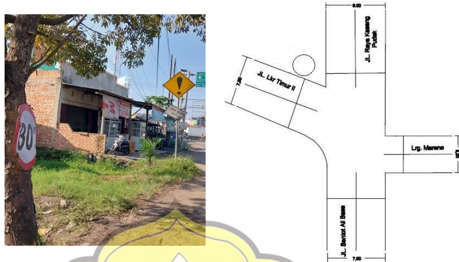
Gambar 4.10 Tiang rambu kecepatan yang tidak sesuai letaknya
