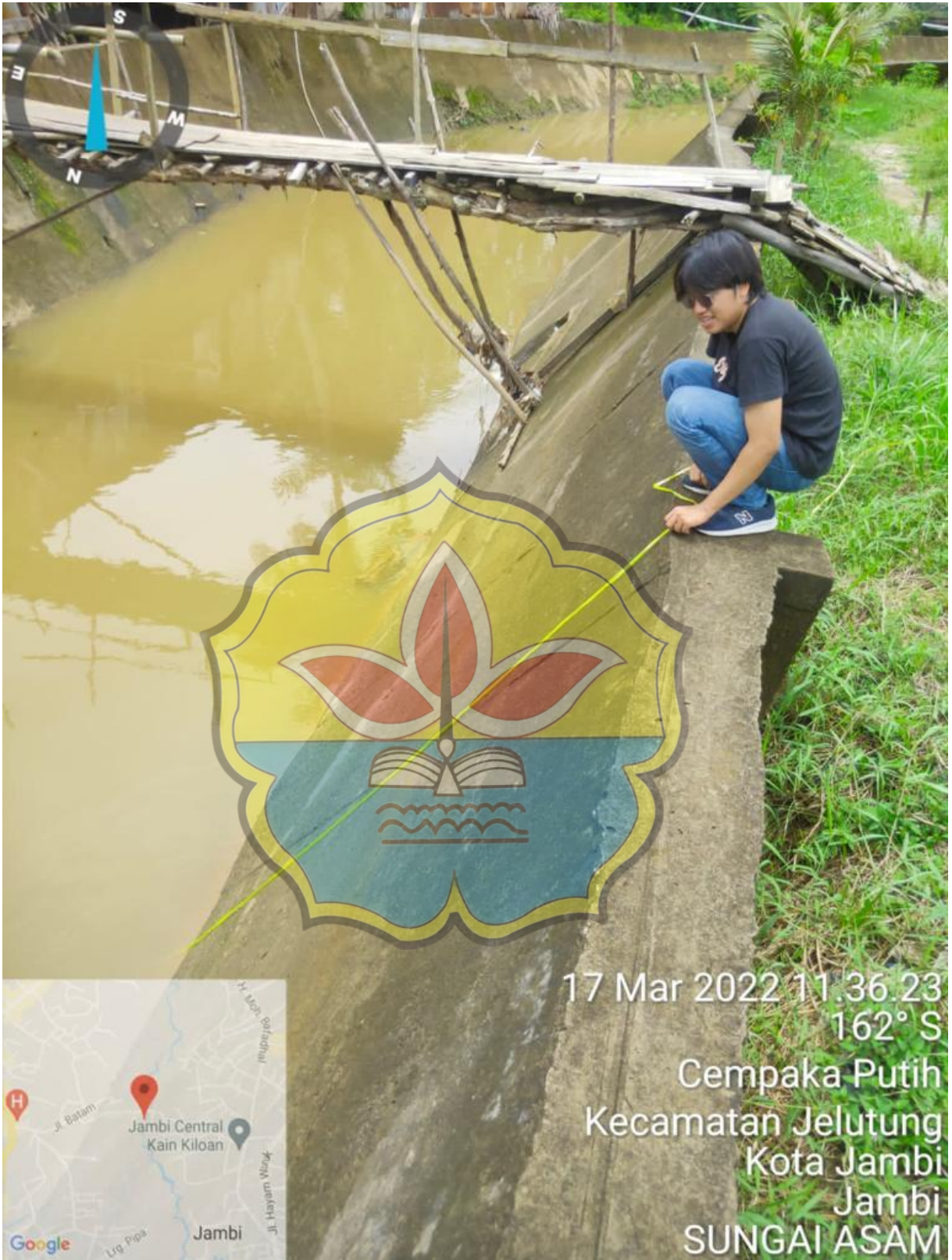
Gambar Dokumentasi 16 – Survei Lapangan
