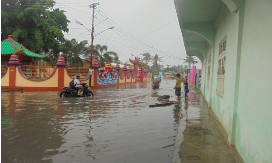
Gambar 5. Kondisi Jalan pada saat Hujan dan Air Drainase Meluap.
