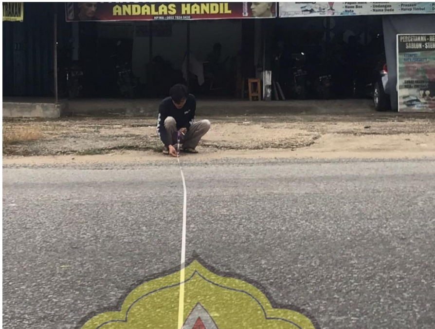
Gambar D13. Survei Pengukuran Geometrik Jalan
