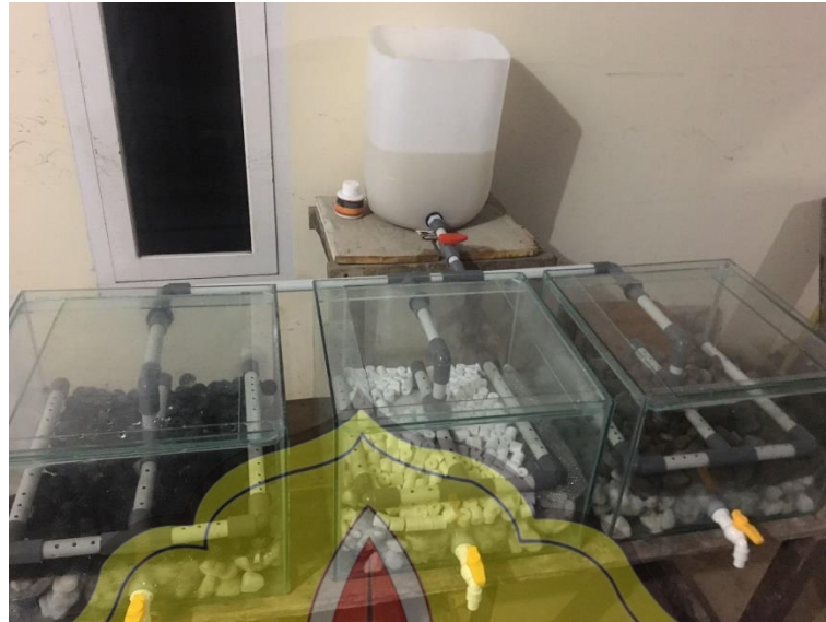
Bak Penampung Awal dan Reaktor Trickling Filter
