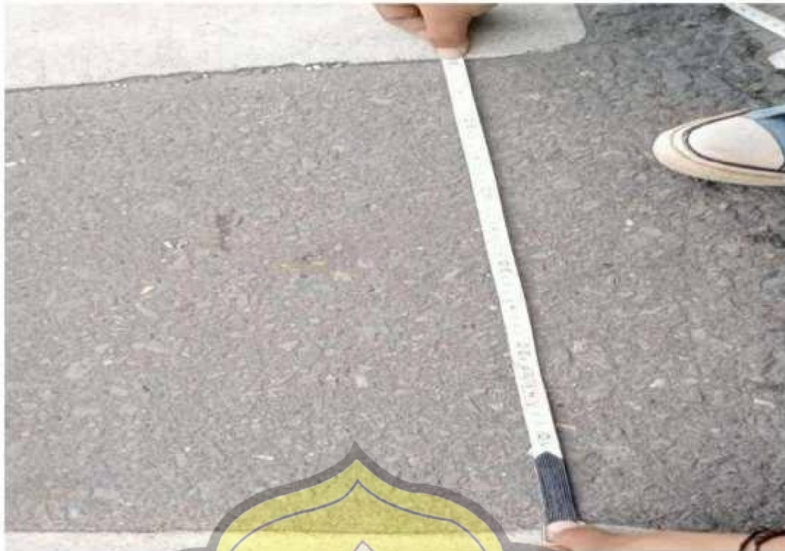
Gambar L.10: Pengukuran Lebar Jarak Antara Rumble Strips di Jalan Yulius Usman
