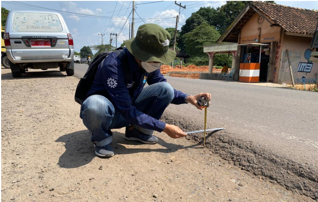
Gambar 7 Foto Pengukuran Ketebalan Badan Jalan
