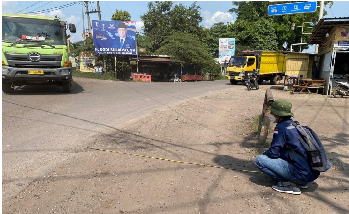
Gambar 5 Foto Pengukuran Rencana Pelebaran Jalan
