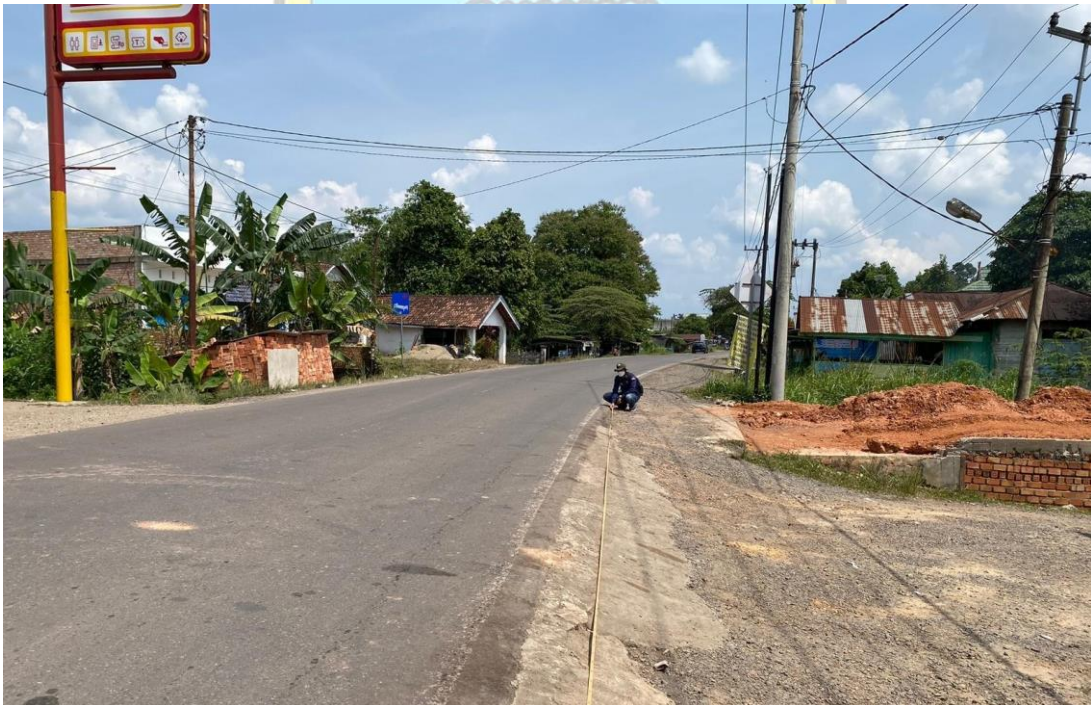
Gambar 12 Foto Pengukuran Rencana Panjang Overlay
