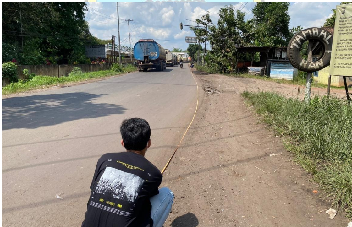
Gambar 10 Foto Pengukuran Rencana Panjang Overlay
