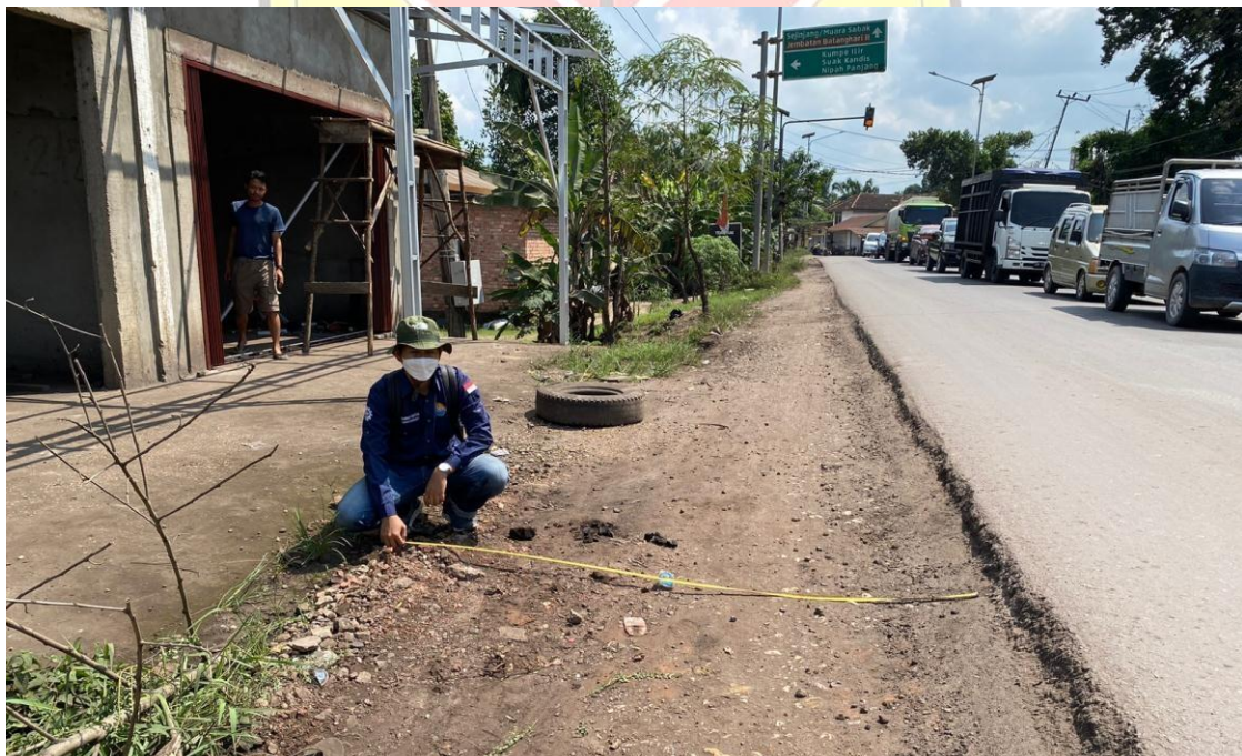
Gambar 6 Foto Pengukuran Rencana Pelebaran Jalan
