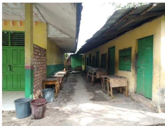
Gambar 6. Bagian Kantin SMP N 20 Kota Jambi
