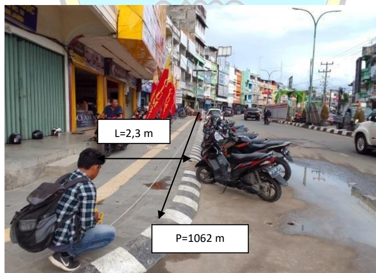
Gambar 4.1 Eksisting Trotoar dilapangan Sumber : Dokumentasi Survei Lapangan 2022
