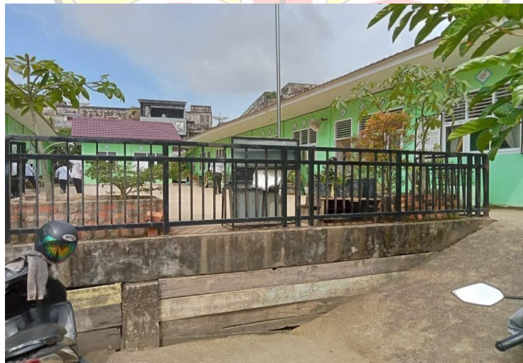
Gedung SDN 163/IV Kota Jambi yang telah di rehabilitasi
