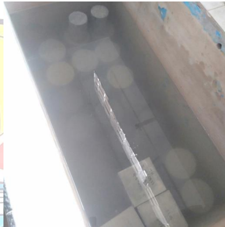
Lakukan perendaman untuk perawatan beton
