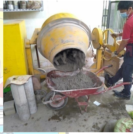
Keluarkan beton segar dari dalam molen
