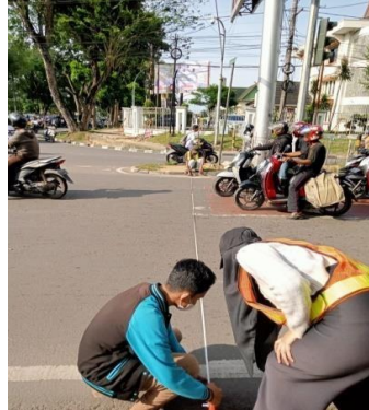
Pengukuran lebar jalan
