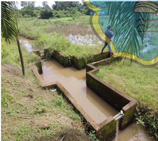
Gambar 7 Bangunan Pintu Telanaipura 6
