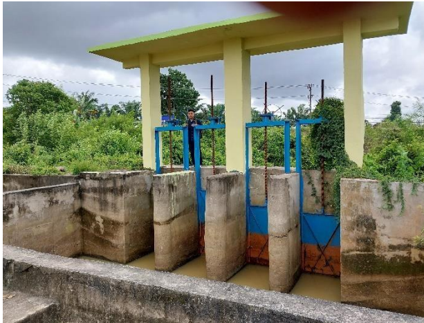
Gambar 1 Bangunan Pintu Pengambilan
