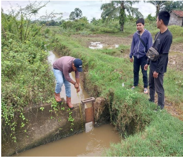
Gambar 5 Bangunan Pintu Telanaipura 1
