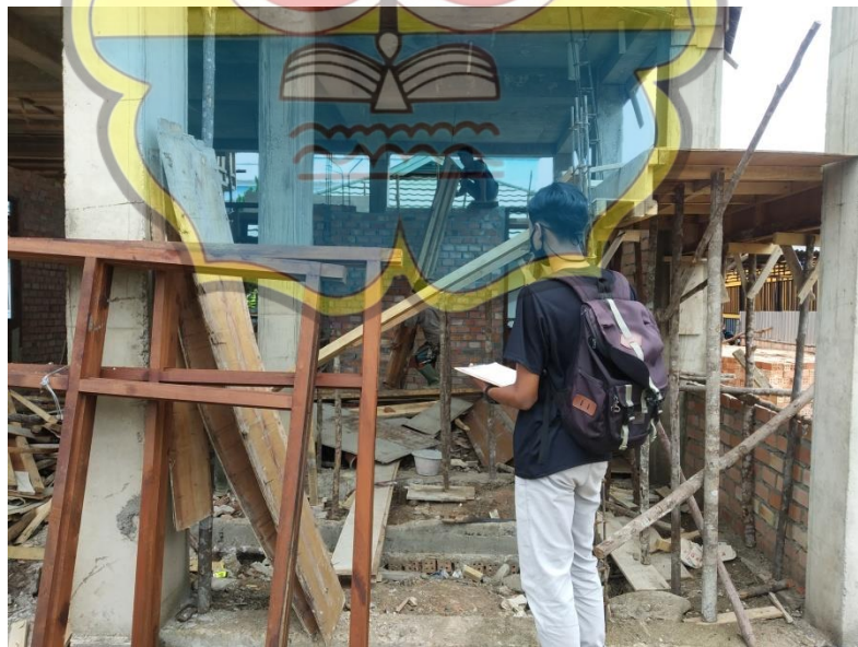
Gambar Pek. Pemasangan Bekesting Tangga
