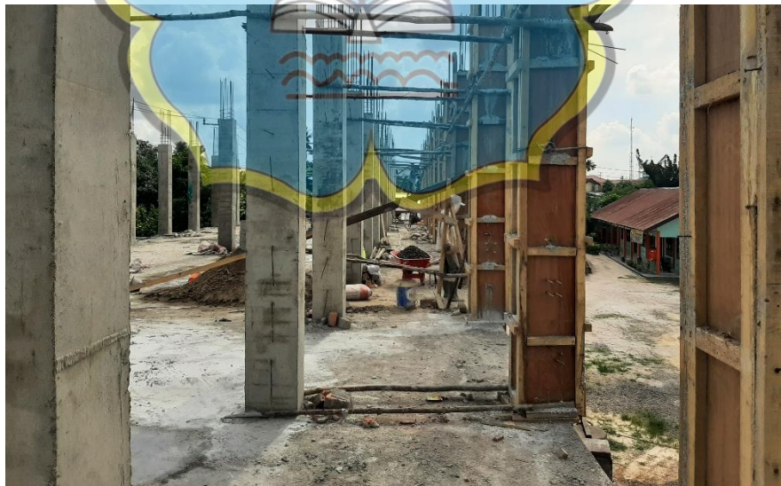
Gambar pekerjaan pengecoran kolom dan bekisting
