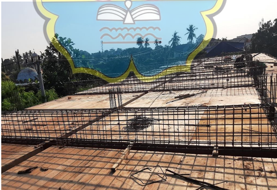
Gambar perakitan besi balok
