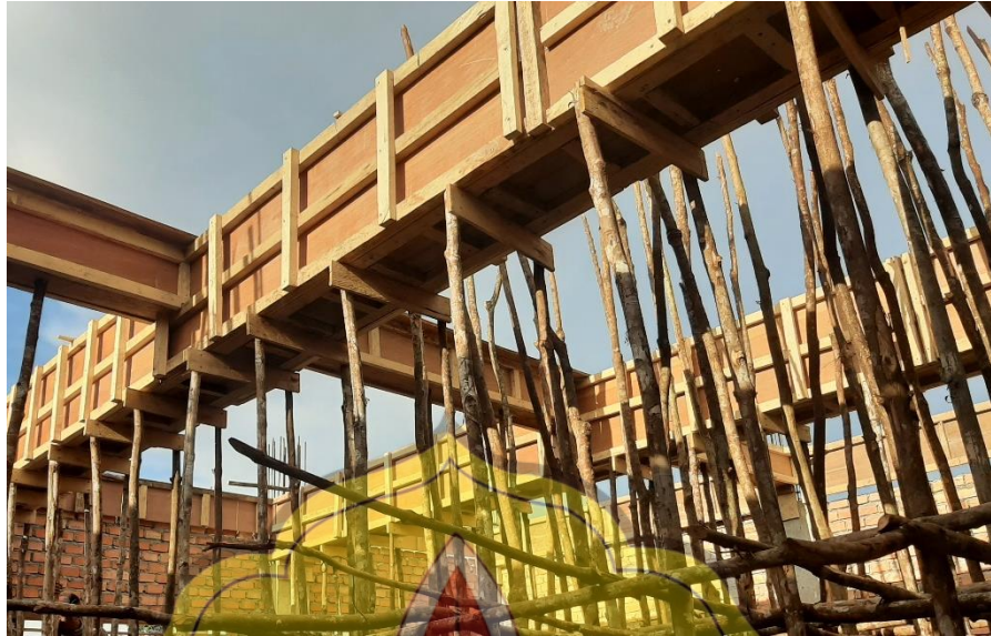
Gambar pekerjaan bekisiting balok B1 dan B3
