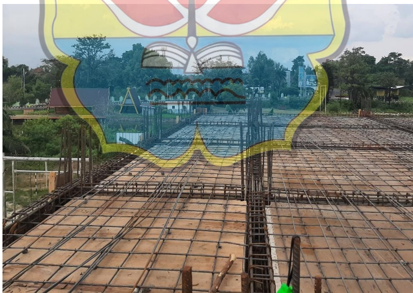
Gambar pembesian plat lantai
