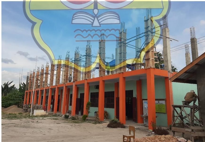
Gambar tampak depan bangunan
