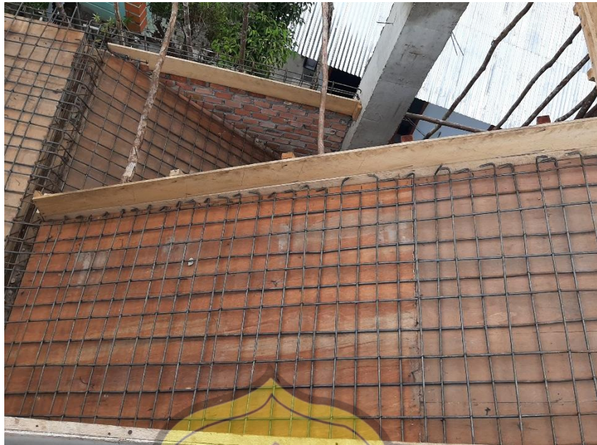
Gambar pembesian plat tangga
