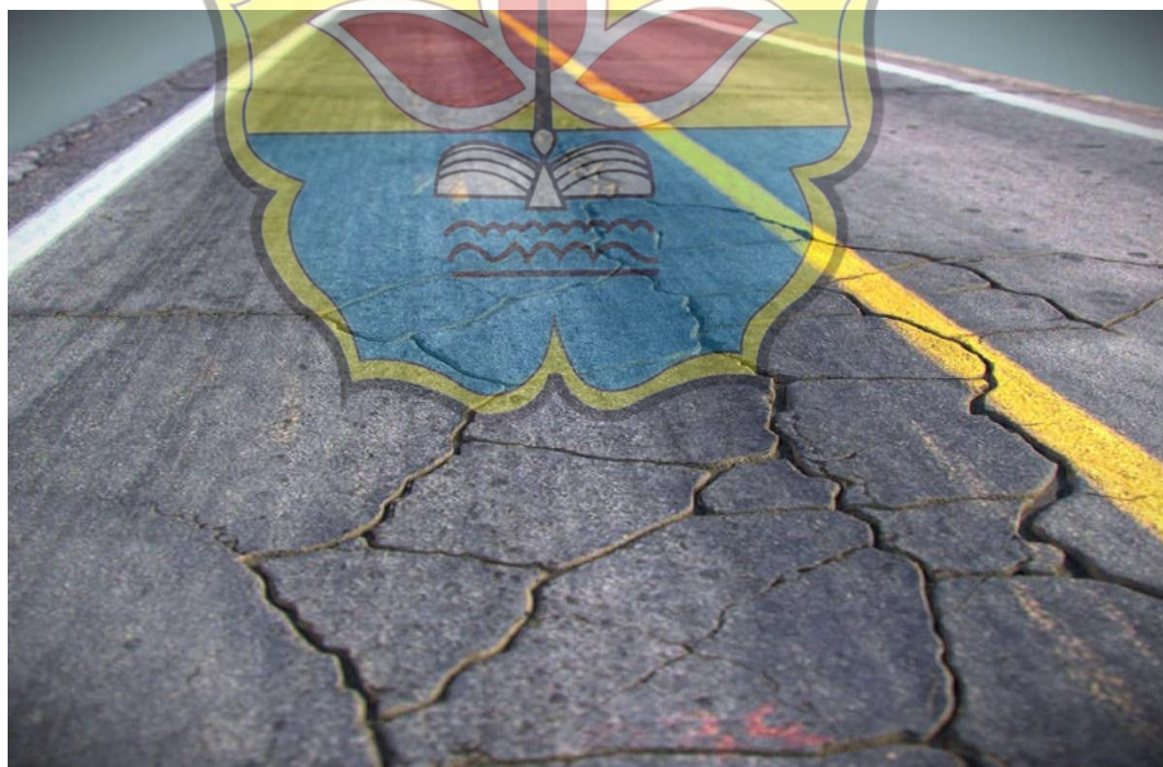
Gambar 2.8 Retak Kotak-Kotak ( Block Cracking )
