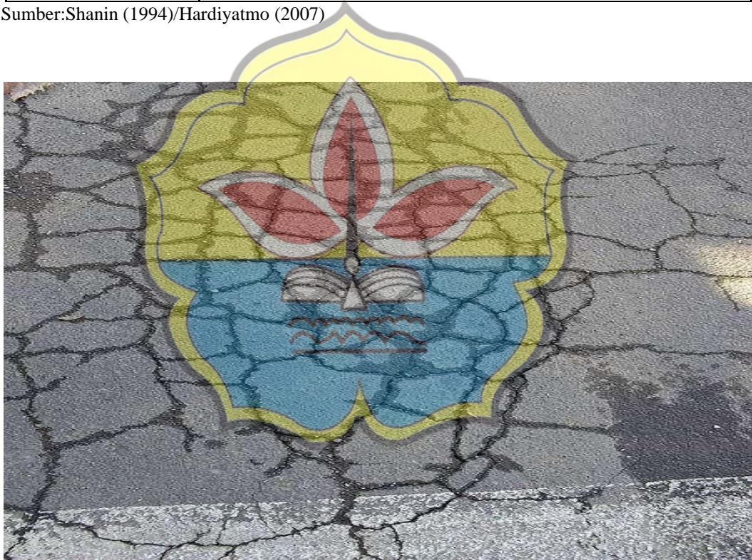
Gambar 2.6 Retak Kulit Buaya ( Alligator Cracking )
