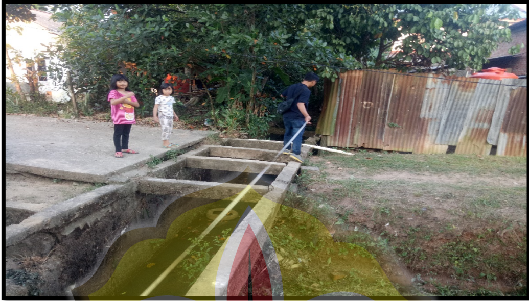
Gambar 1 : Pengukuran Dimensi Saluran Drainase Perumahan Kota Baru Indah
