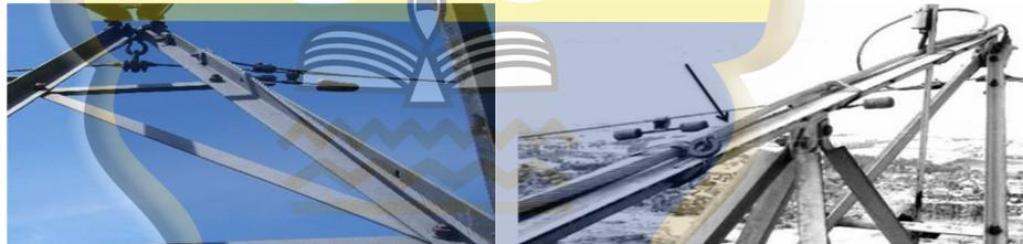
**Gambar 2.4** Konduktor penghubung, kawat GSW/OPGW ke tanah
