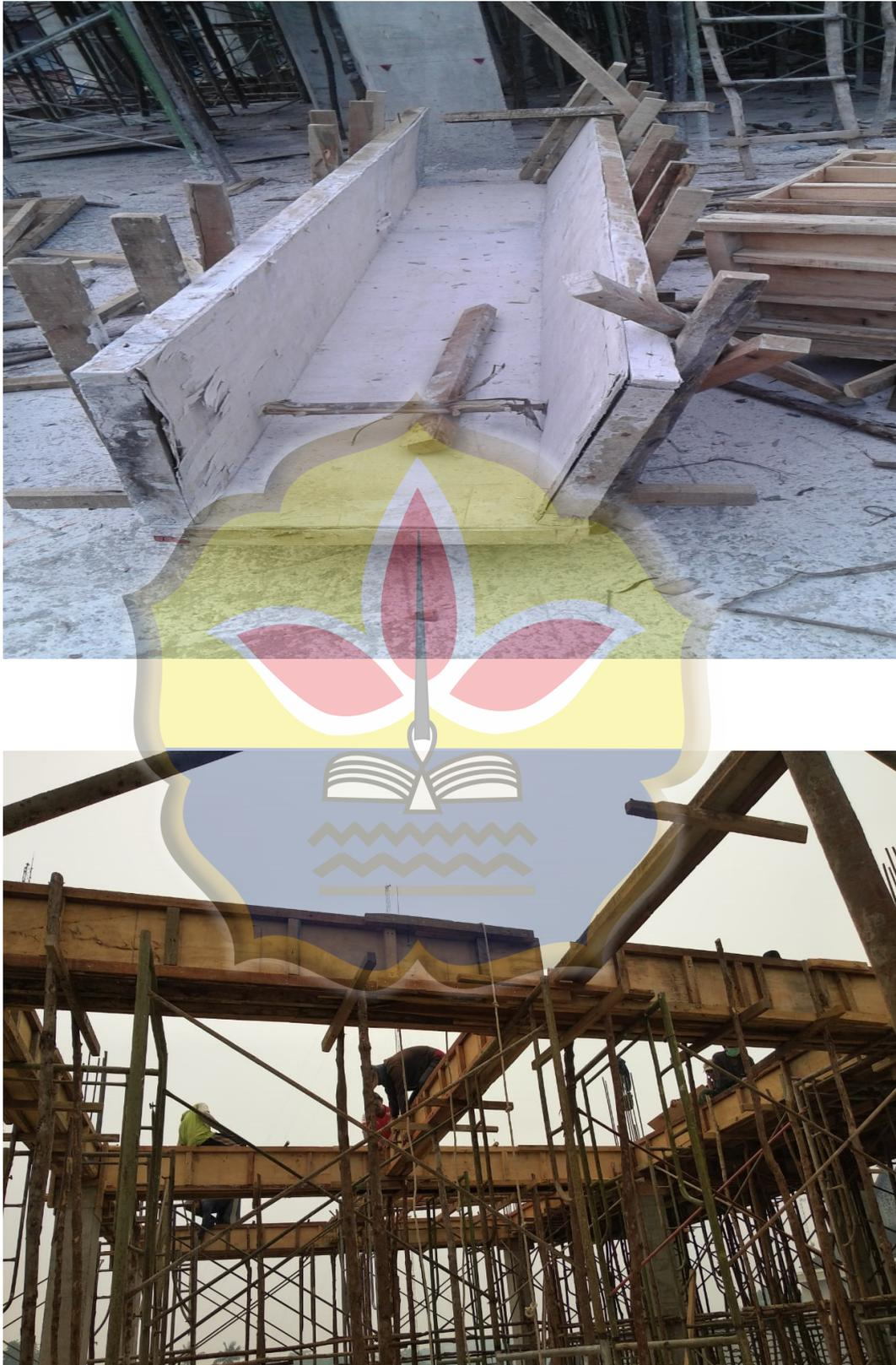
Gambar A.4.4 Pemasangan Bekisting Balok
