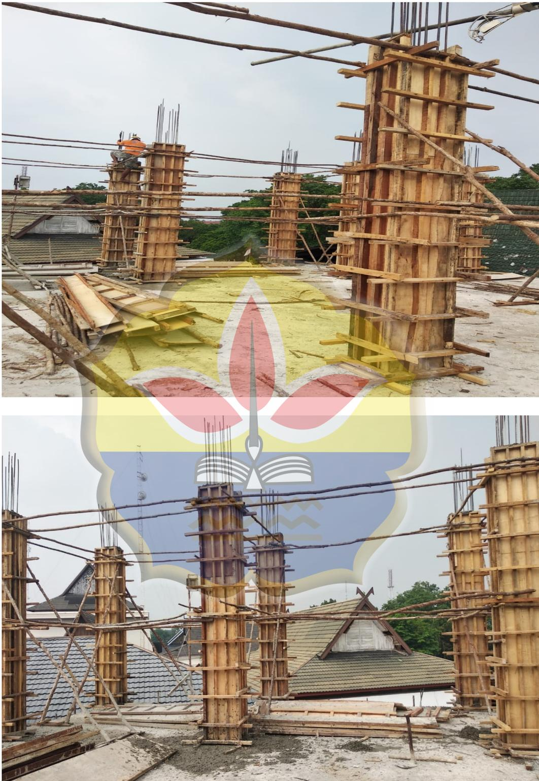
Gambar A.4.2 Pemasangan *Bekisting* Kolom
