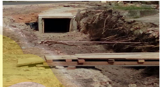
Gambar : 3.2. Pemasangan Beton Pracetak
