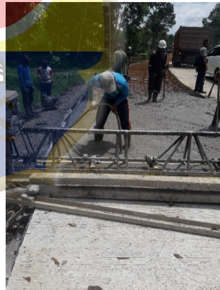
Pemadatan Beton Ready Mix dengan menggunakan Concrete Vibrator
