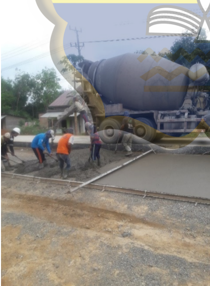
Perataan Beton Lean Concrete (LC) yang telah dihamparkan
