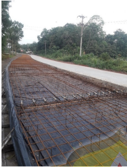
Pemasangan Penulangan diatas elastik
