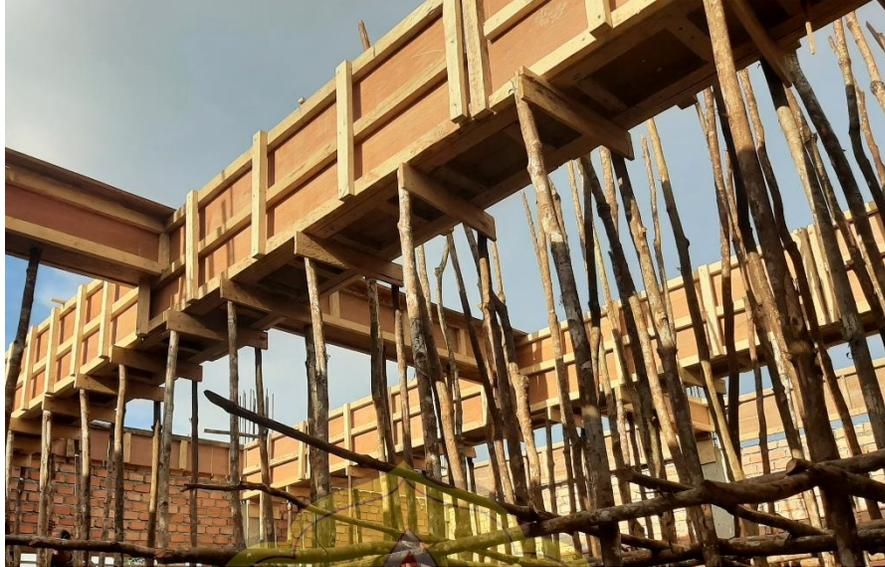
Gambar pekerjaan bekisting balok B1 dan B3
