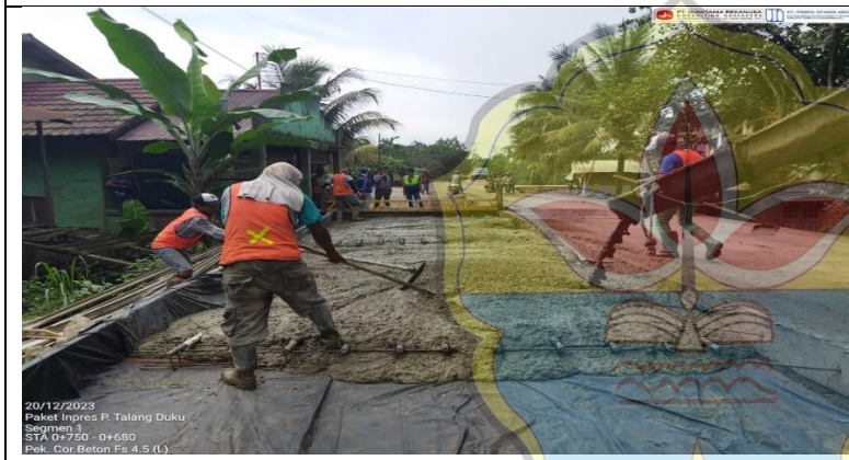
Dokumentasi segmen I Pekerjaan Pengecoran Perkerasan Beton Semen Fast Track 24 Jam
