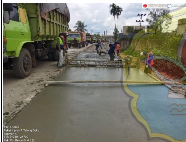
Dokumentasi segmen 4 Pekerjaan Pengecoran Perkerasan Beton Semen Fast Track 24 Jam
