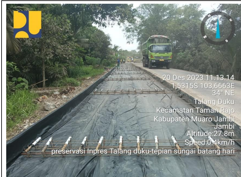
Dokumentasi segmen I Pekerjaan Pembesian Dowel, plastik hitam dan dudukan Dowel Perkerasan Beton Fast Track 24 Jam
