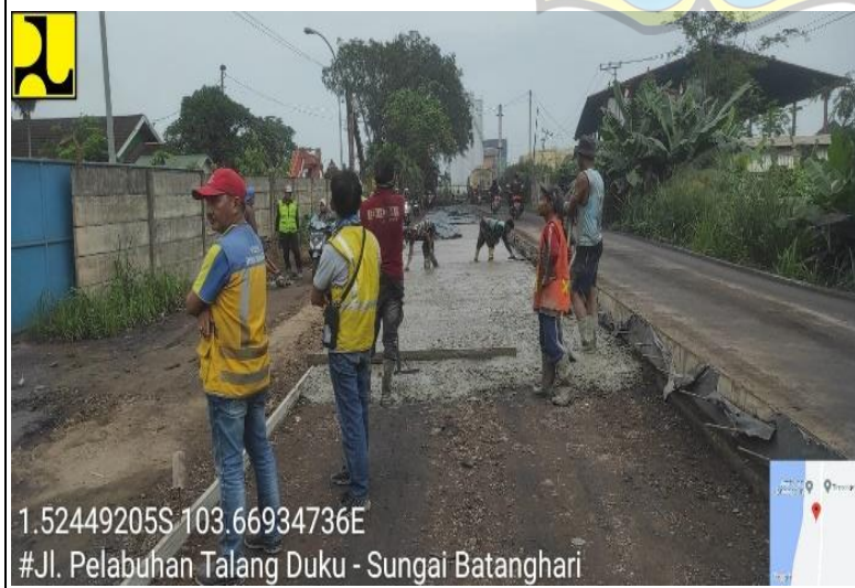
Dokumentasi segmen 2 Pekerjaan Pengecoran Lapis Fondasi Bawah Beton Kurus
