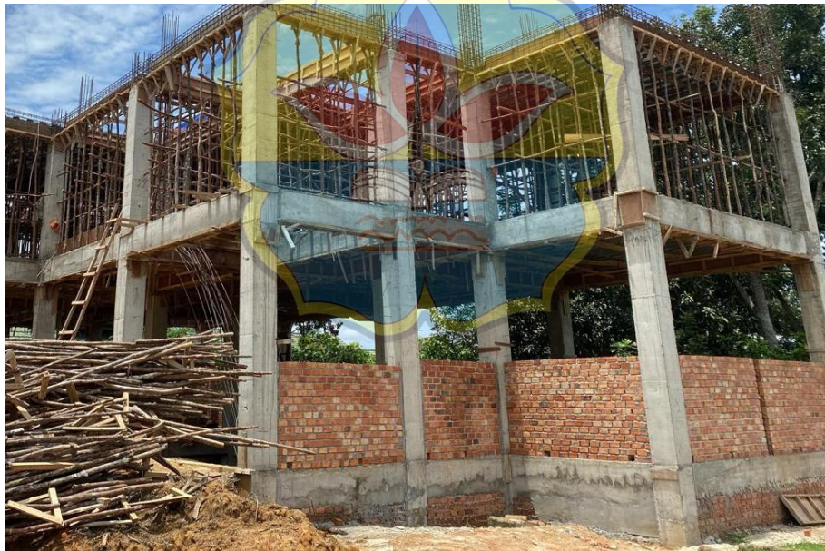
Gambar hasil Pekerjaan pasang batu bata
