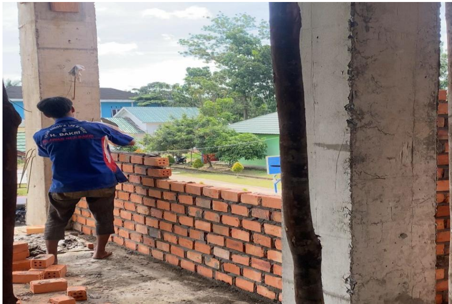
Gambar Pekerjaan pasang batu bata
