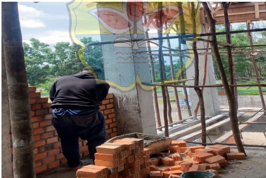
Gambar Pekerjaan pasang batu bata
