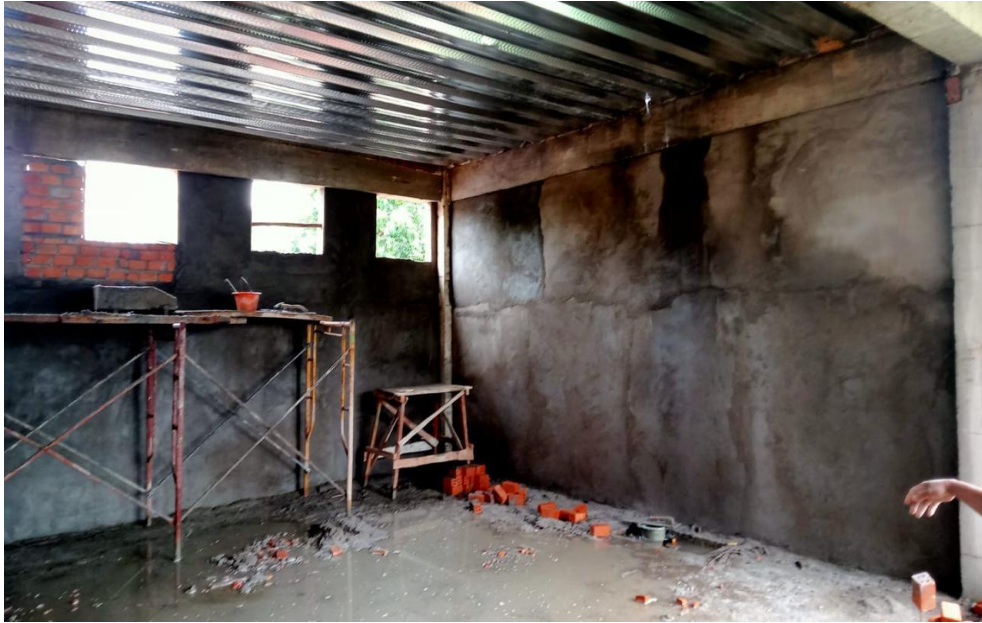
Gambar hasil Pekerjaan plasteran dinding + kolom
