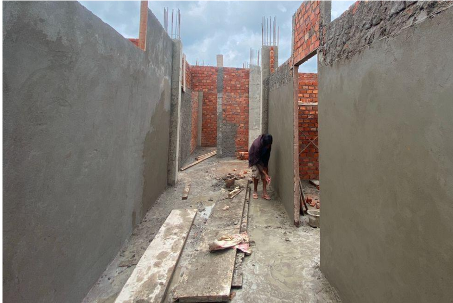
Gambar Pekerjaan plasteran dinding + kolom
