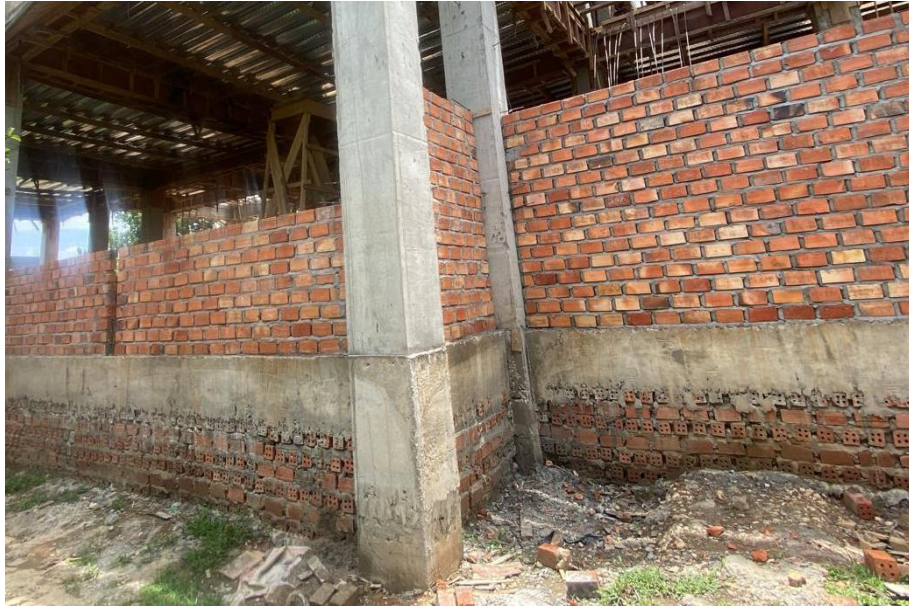
Gambar hasil Pekerjaan pasang batu bata
