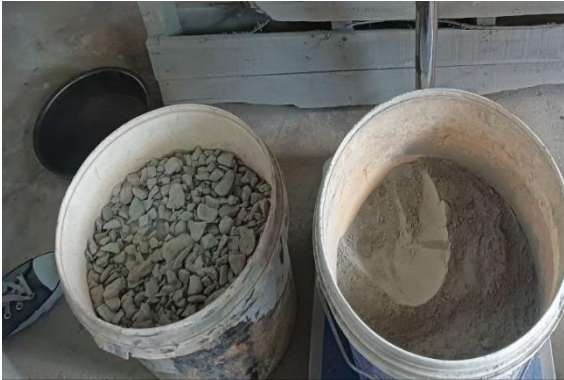
Penyiapan Material Untuk Pengecoran Beton Kaca 12%
