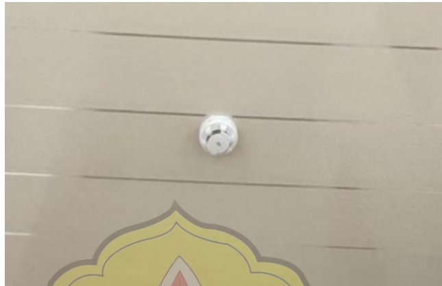
Gambar 4.15 Deteksi Asap Sumber : Data Olahan (2024)
