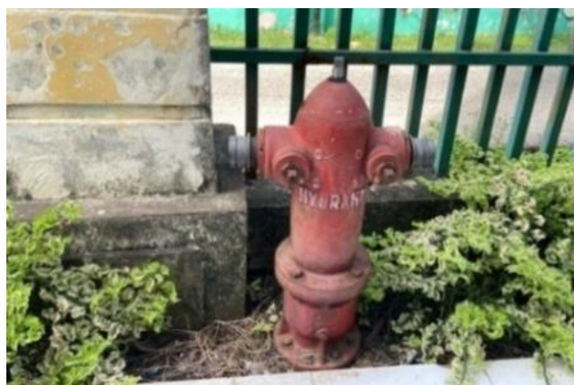
Gambar 4.9 Hidran Halaman
