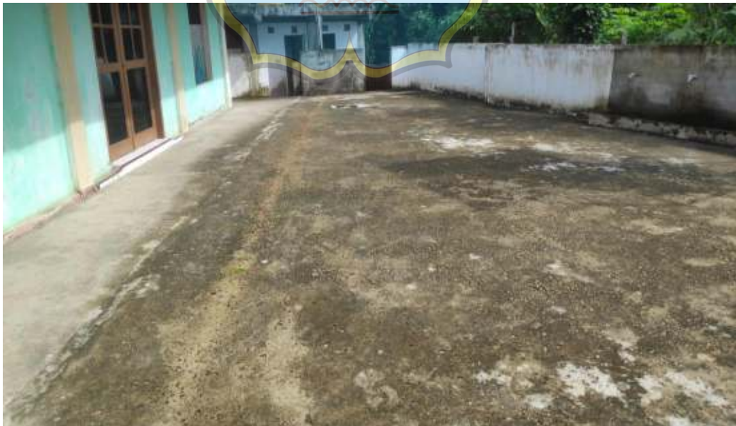
Gambar 4. Tempat rencana pembangunan bak
