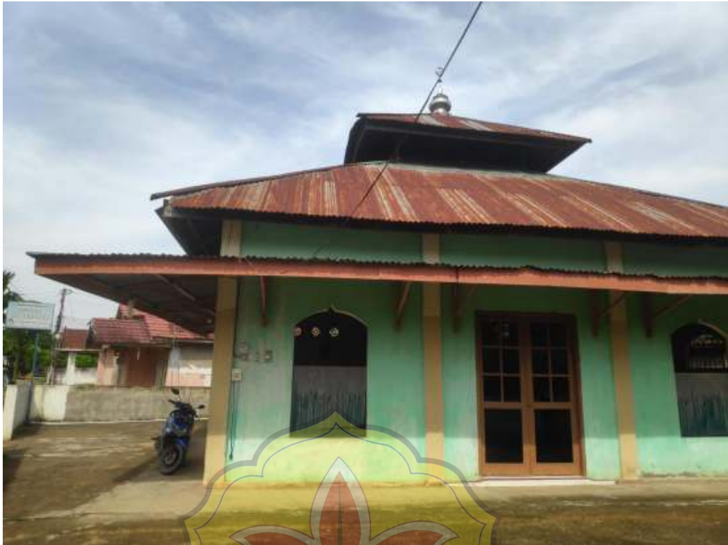
Gambar 3. Pemanenan air hujan melalui atap bangunan masjid
