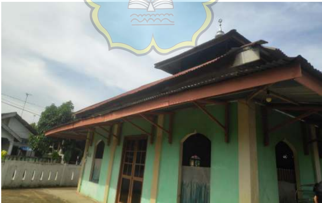
Gambar 2. Pemanenan air hujan melalui atap bangunan masjid
