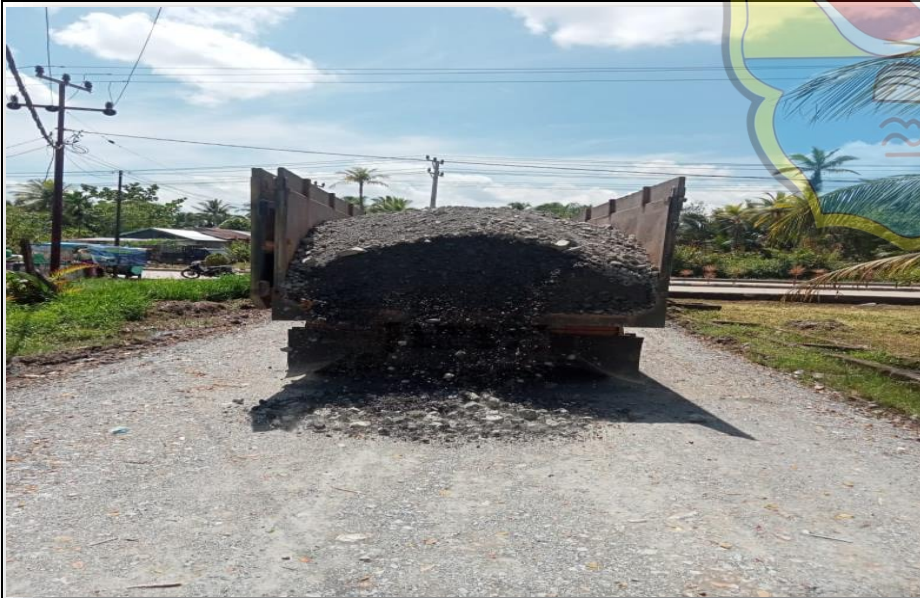
DATANG NYA LAPIS PONDASI AGREGAT KELAS A
