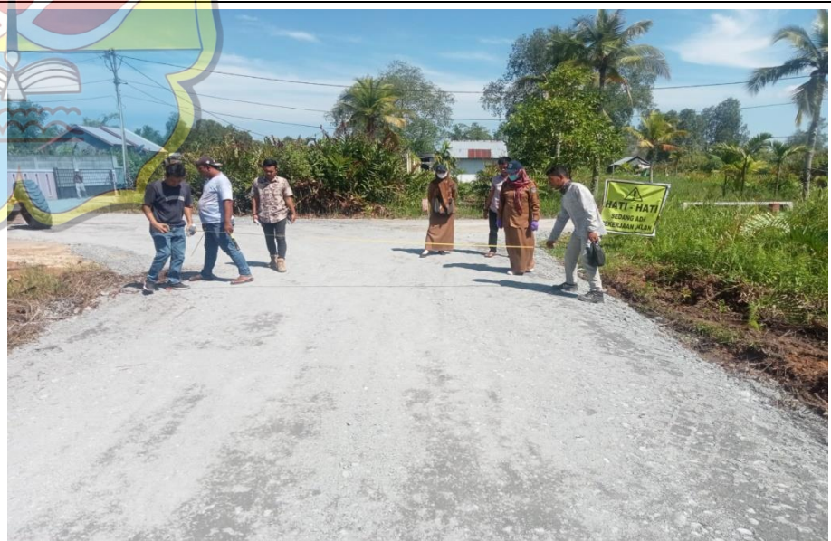
SELESAI NYA LAPIS PONDASI AGREGAT KELAS A
