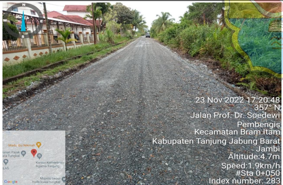
SELESAI NYA LAPIS PONDASI AGREGAT KELAS A
