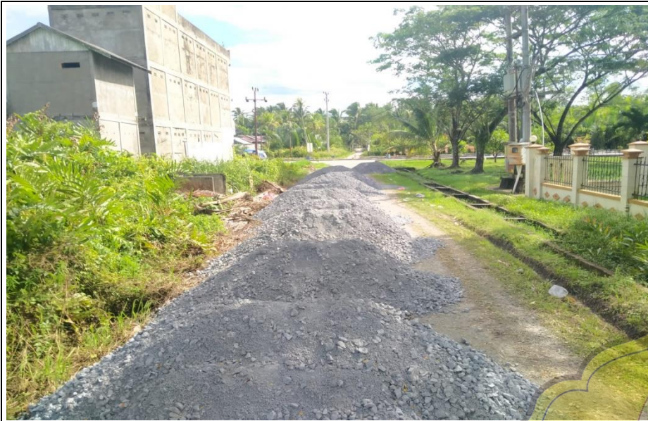
DATANG NYA LAPIS PONDASI AGREGAT KELAS A
