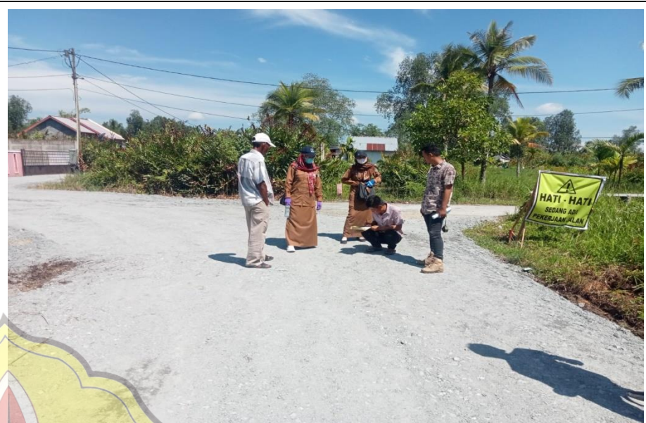
SELESAI NYA LAPIS PONDASI AGREGAT KELAS A
