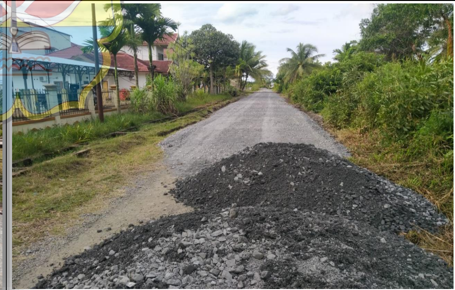
DATANG NYA LAPIS PONDASI AGREGAT KELAS A
