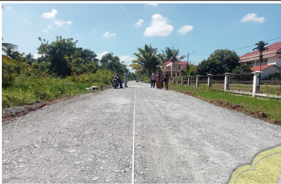
SELESAI NYA LAPIS PONDASI AGREGAT KELAS A
