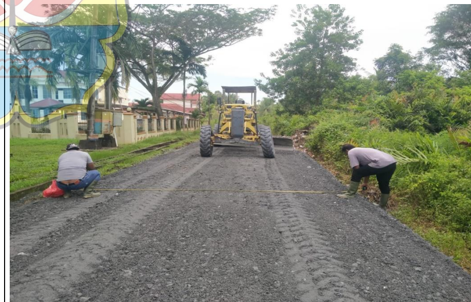
DI RATAKAN DAN DI PADAT KAN AGREGAT KELAS A
