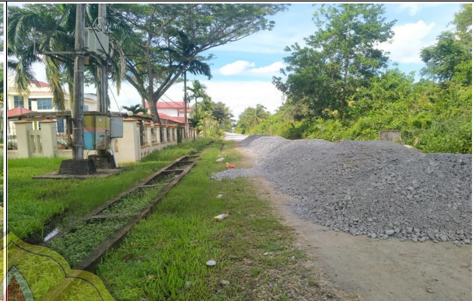
DATANG NYA LAPIS PONDASI AGREGAT KELAS A
