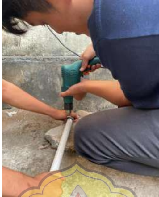
Gambar 3 Pengeboran Saluran Pipa Tray Aerator
